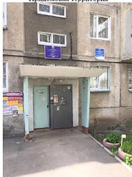
Вход в подбезд
